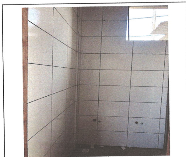
FOTO 22: Assentamento do revestimento cerâmico (bloco 3)
