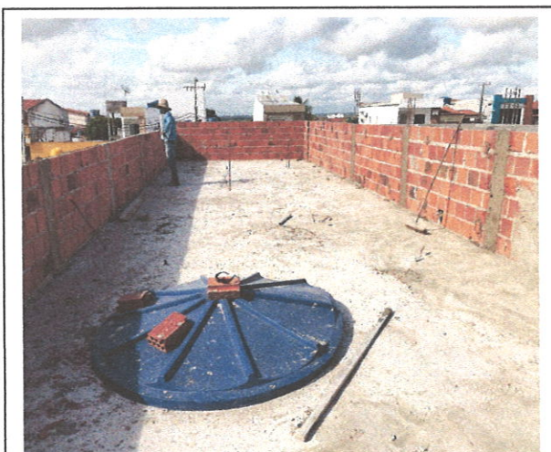
FOTO 01: Levante de alvenaria da platibanda (bloco 3)
