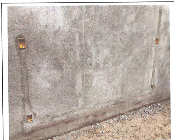
FOTO 05: Chumbamento das caixinhas 4x2 – Elétrica (bloco 2)
