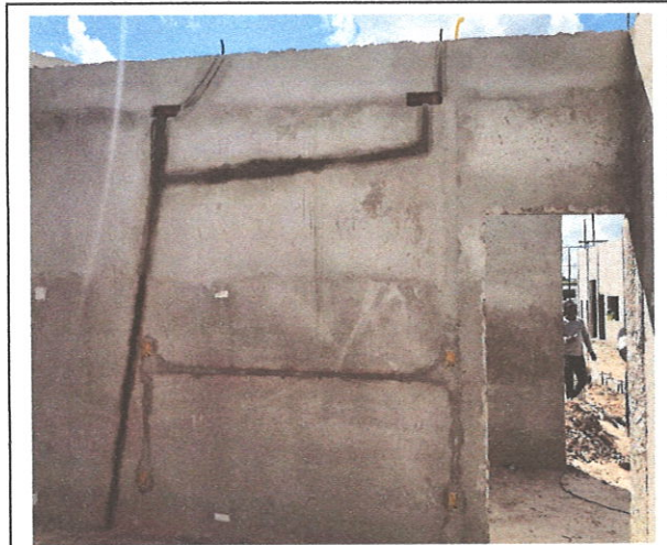
FOTO 09: Instalação da infraestrutura para ar condicionado
