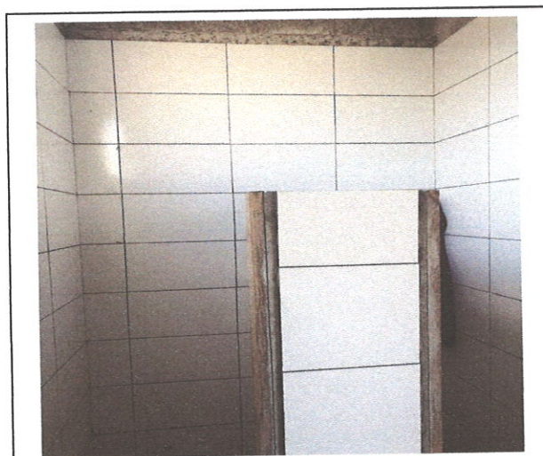
FOTO 21: Assentamento do revestimento cerâmico (bloco 3)
