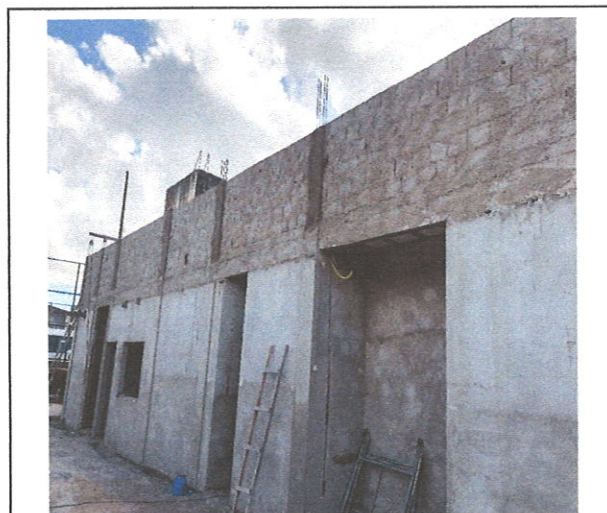
FOTO 02: Chapisco da platibanda (bloco 3)
