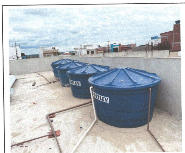
FOTO 24: Instalação das caixas d'água e rede de água fria
