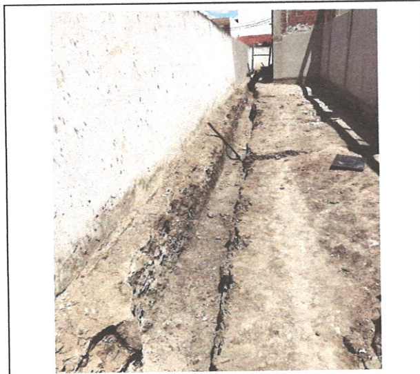
FOTO 13: Escavação rede de esgoto
