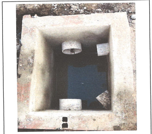
FOTO 14: Caixas de passagens (Esgoto)
