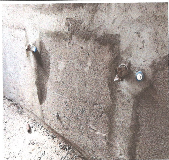
FOTO 27: Rede de esgoto e água fria
